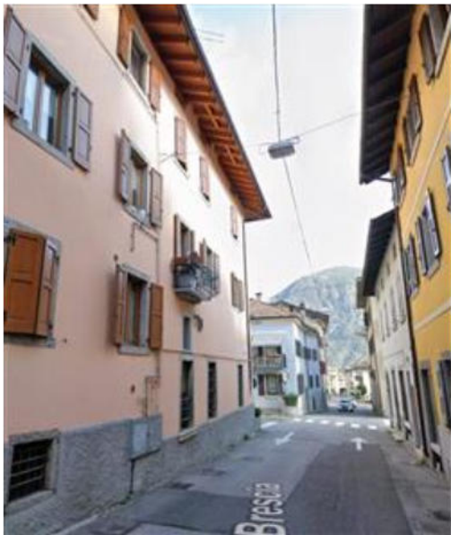
AFFACCIO SU VIA BRESCIA VISTA DA SUD
